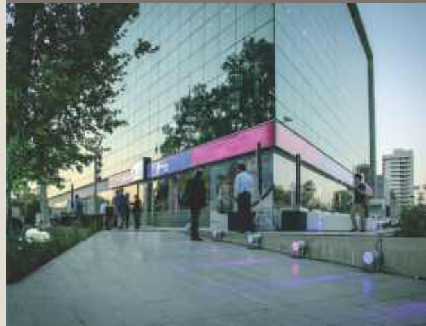
Nuevas instalaciones de la Delegación Río Cuarto.
