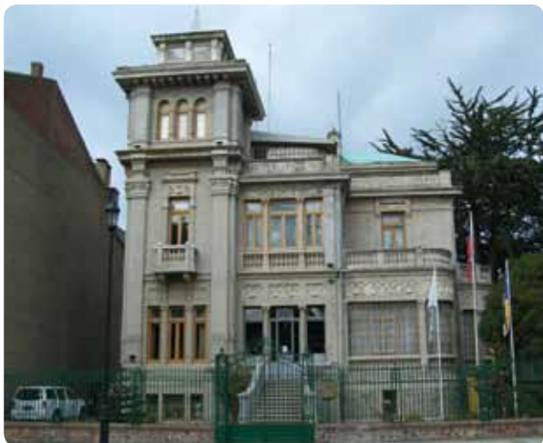
Edificio consistorial, comuna de Punta Arenas
