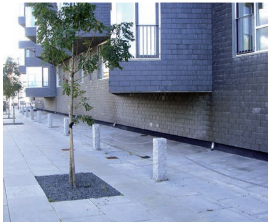
Protección de obstáculo a baja altura en itinerario urbano.
