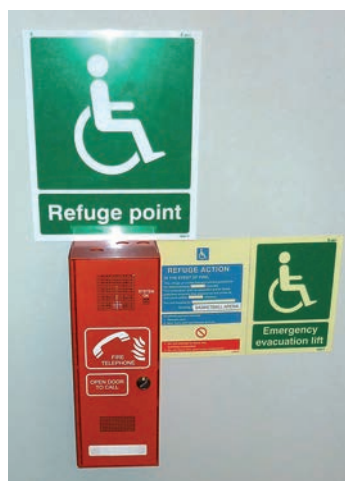
Señalización de zona de refugio.
