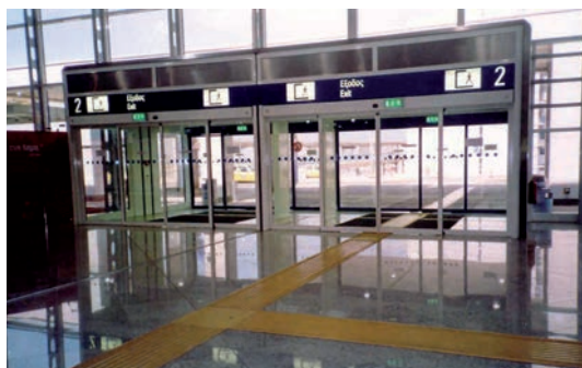
Acceso a terminal de aeropuerto con encaminamiento y puertas automáticas.
